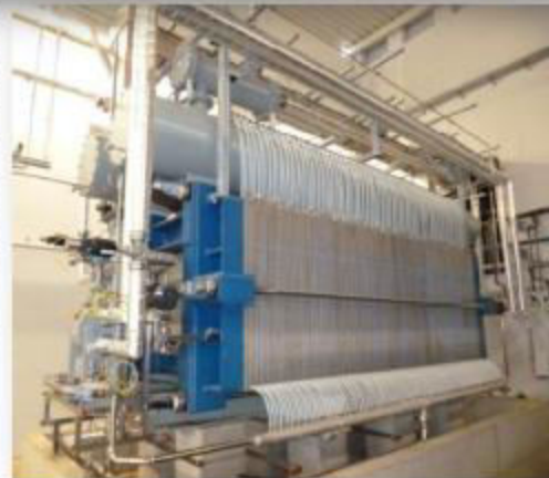
Elektrolyseurhalle 2 MW el | Elektrolyseur
