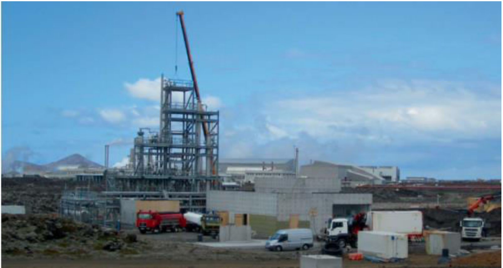
Errichtung der Pilotanlage von CRI auf Island, 5.000 t Methanol pro Jahr
