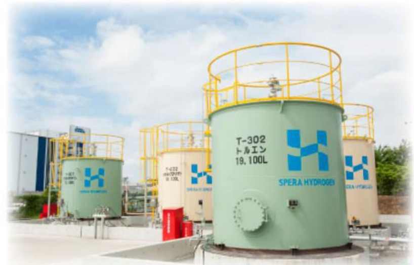
Pilotanlage bei Chiyoda in Japan: Speicherung von 10.000 \text{ Nm}^3 \text{ H}_2 Mittels Methylcyclohexan in Tanks à 20 \text{ m}^3
