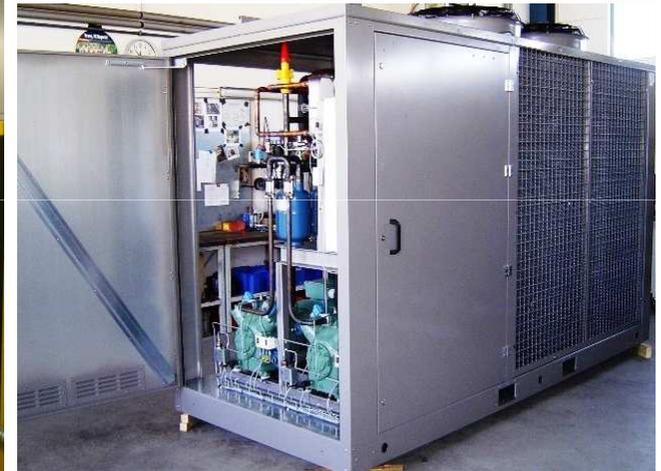
Spezipack, Klingenberg: Produktionsabwärme > 2 Kältemaschinen je 39,5kW, Heizung Büro/Sozial im 2-Schicht-Betrieb mit 10.000-Liter-WärmeHamster©
